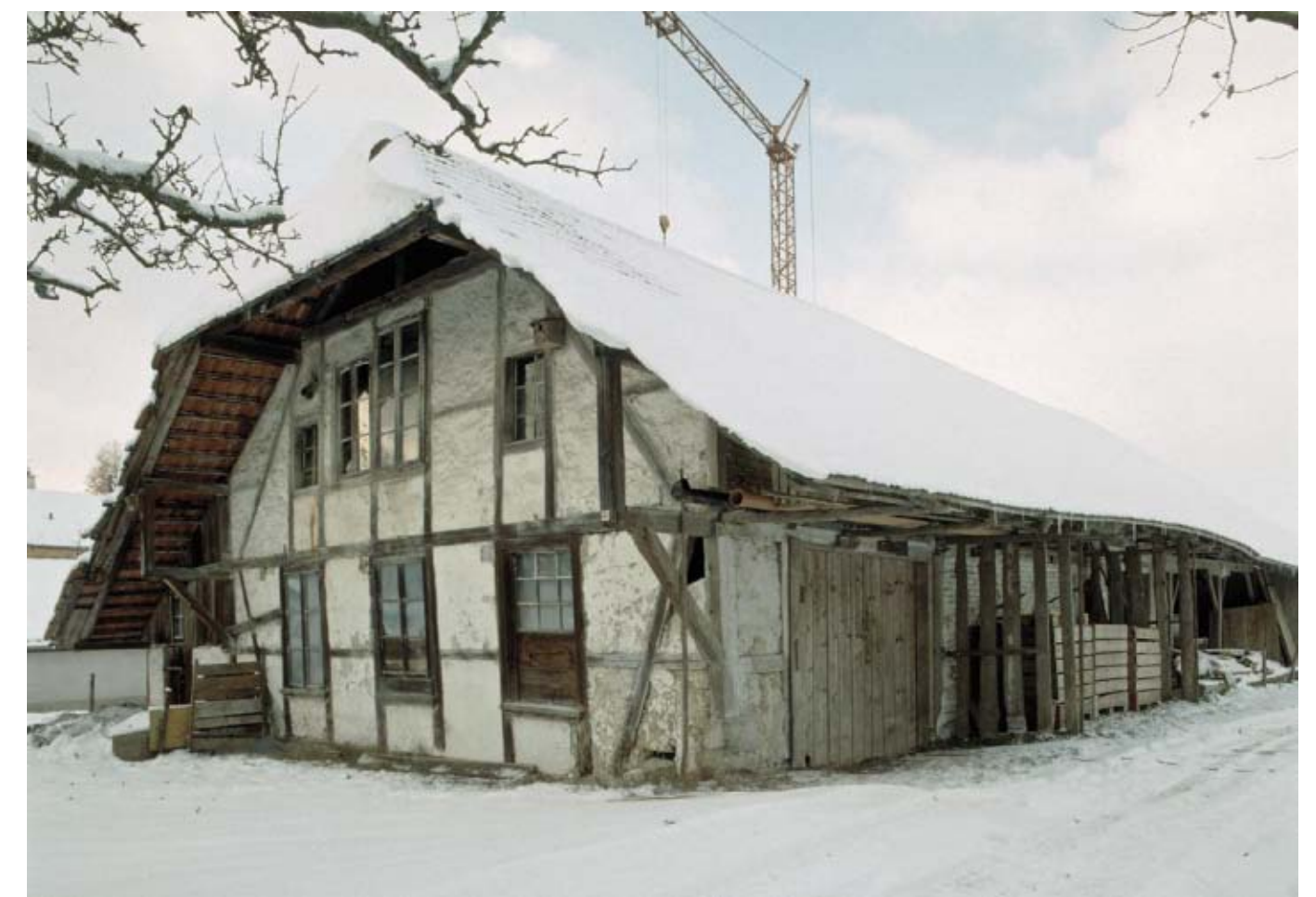
Die Röhrenhütte in Bärswil vor Beginn der archäologischen Untersuchung 1988 (Foto ADB Alex Ueltschi).
